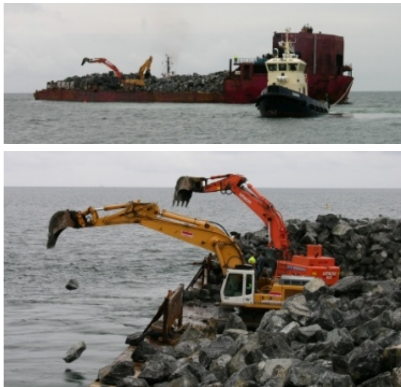
Figur 4. Udlægning af sten på Læsø Trindel (BlueReef-projektet).
